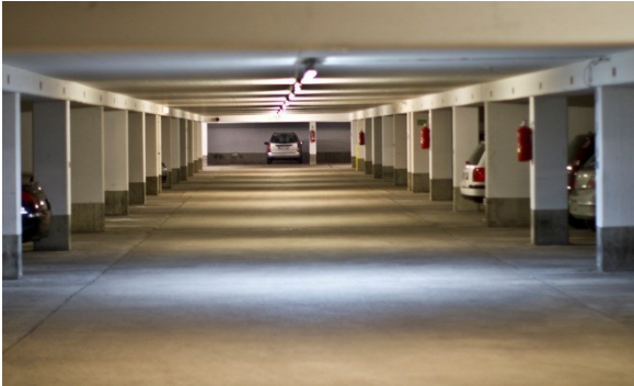
Vorne CCFL-Leuchte – Hinten Leuchtstoffröhren T8
